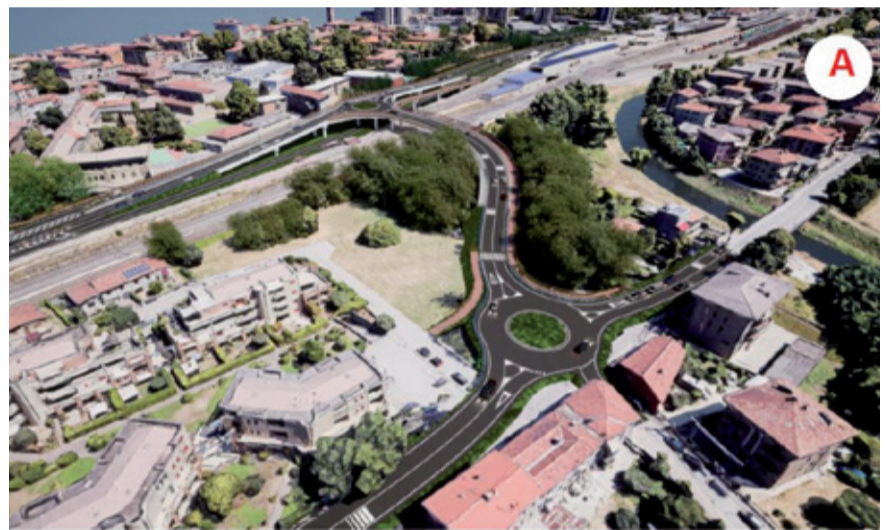
Il cavalcaferrovia di Via Maganza, un'opera prevista dal piano regolatore della città dal 1958 e mai realizzato. Esso ha origine in Via Maganza nel punto in cui fino a poco tempo fa sorgeva un distributore di benzina (abbattuto nel 2015), scavalca la ferrovia e giunge su una rotonda sopraelevata che permette agli utenti della strada di dirigersi verso le rampe che conducono sia verso l'area della stazione, sia verso Viale San Lazzaro (sono previste piste ciclopedonali su entrambi i lati del cavalcaferrovia, permettendo anche a pedoni e ciclisti di andare sia verso la stazione, sia verso Viale San Lazzaro).
